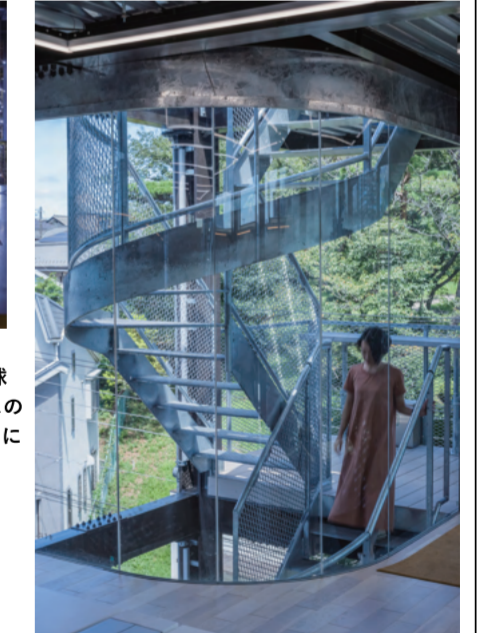
念密な構造計算によるシンプルな鉄骨階段と階段に沿った曲線ガラス
